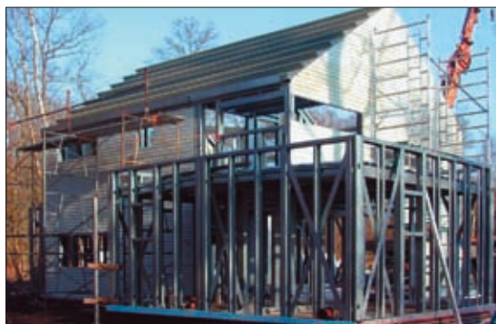
Prototype d'une maison à ossature acier, sur le site du CSAC. (Arch. : V. SALMON)
