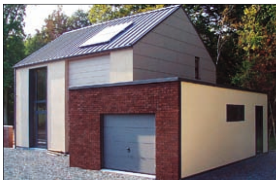
Prototype d'une maison à ossature acier
