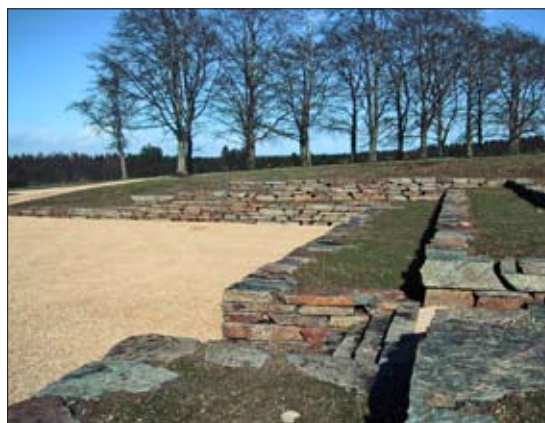
Château-ferme de Cokaifagne (Jalhay)
