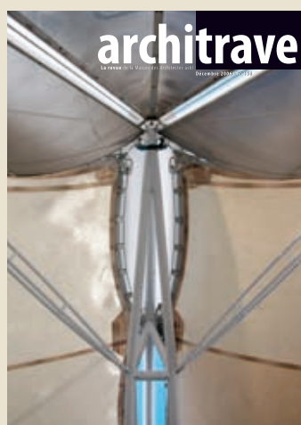
Détail station de métro « Erasme » © Samyn and Partners, architects & engineers voir « L'invité architrave » page 16
