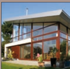
• David Autem habitation unifamiliale Belceil - réalisation 2006
