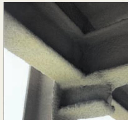
Promat s.a., le spécialiste par excellence en matière de protection incendie passive, propose une nouvelle gamme de mortiers projetés à base de vermiculite pour le revêtement de constructions en acier et en béton dans les bâtiments.
