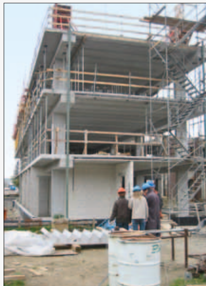
Vue du chantier
