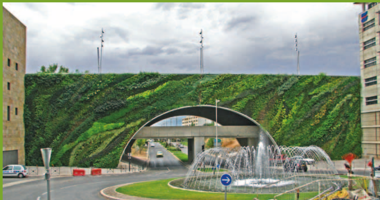
© Patrick Blanc - Pont Juvenal - Aix-en-Provence - avec le mur végétal
