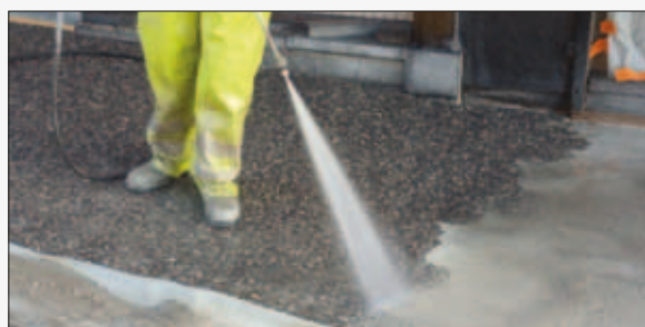
3) Elimination de la pellicule de surface n'ayant pas fait prise
