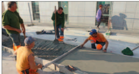
1) Le béton n'est pas vibré mais doit être bien lissé
