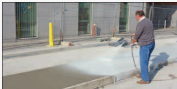
2) Pulvérisation du retardateur de prise à la surface du béton dès la fin de sa mise en œuvre
