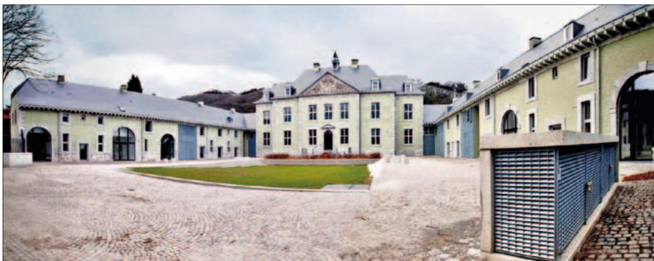
Réaffectation du Château Nagelmackers en 20 logements et un espace entreprise – Angleur – AW architectes snc – Photo © AWa
