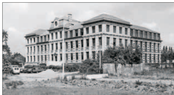
Rénovation de l'usine « Sambre et Moselle » à Montignies-sur-Sambre – arch Romain, 1993 – Photo © J.-P. Brohez
