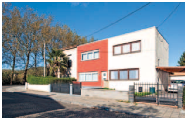
Groupe de trois maisons construites par L.H. De Koninck – Liège – Photo © Héliène Erpicum
