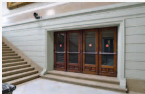
Protection contre l'incendie de portes à panneaux historiques – Musée royale de l'Afrique centrale à Tervueren.
