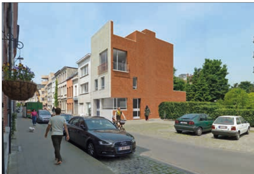
Projet Kattenberg, Borgerhout (Anvers) – Architecten Broekx-Schiepers pour le compte d'AG VESPA
