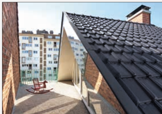
Projet Tichel, Gand — architectes de vyllder, vinck, taillieu pour le compte de sogent — Photo: Filip Dujardin
