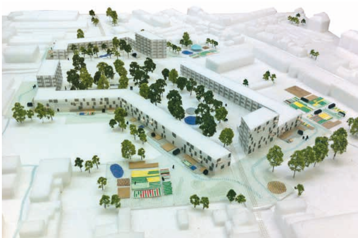
Projet Ter Hoogte, Wilrijk (Anvers) — OFFICE Kersten Geers David Van Severen pour le compte de AG VESPA
