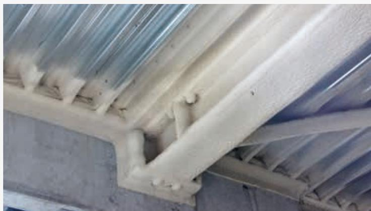
EN 13381-1 sur la base de la température maximale dans le vide et la température maximale à la surface. Ces températures sont déterminées par les matériaux dans lesquels la structure porteuse et la plaque porteuse sont réalisées. La température critique de l'acier peut être déterminée suivant l'Eurocode (voir ci-dessous). Ensuite cette température sera comparée à la température mesurée dans le vide pendant l'essai-feu.
