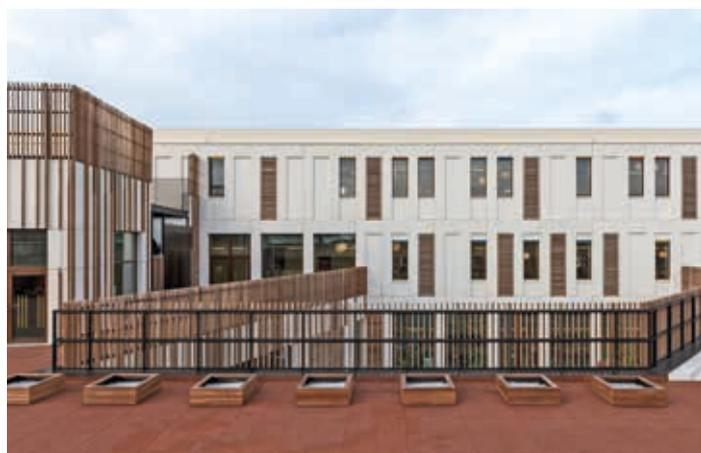
Le bâtiment est une école passive grâce à son isolation plus épaisse, à l'attention méticuleuse portée à l'étanchéité à l'air, à la protection solaire, à un système de ventilation avec récupération de chaleur, et à une menuiserie passive à triple vitrage.
