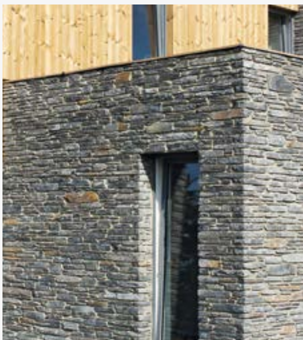
Maison unifamiliale à Bièvre réalisée en grès schisteux similaire à ce qui existe en grande majorité dans le village – arch. Philippe Jourdan et Barbara Rotundo – Grand Prix d’Architecture de Wallonie 2019 – Photo © Caroline Huberty
