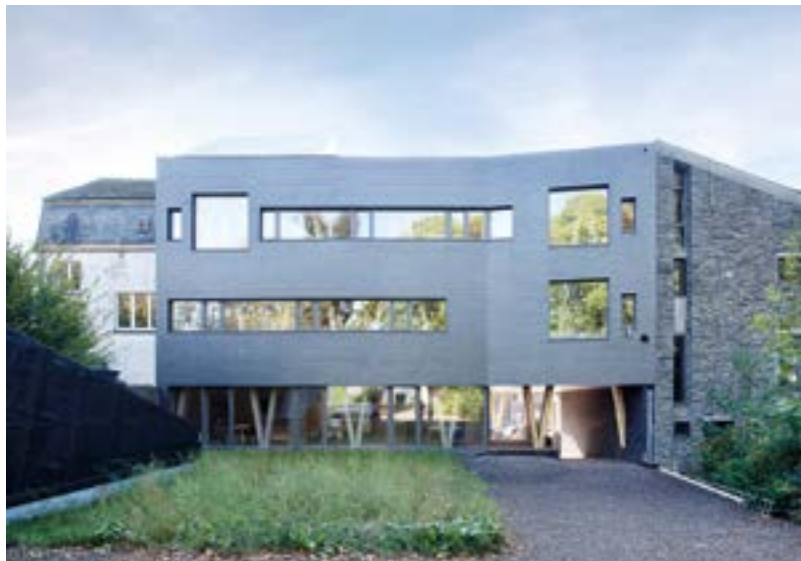
Bureaux pour une étude notariale à Bastogne – David + Leblan, architectes (Malmedy) – Écorce, ingénierie & consultance – www.damienfranzen.be – © Photo CaroLine Dethier Ensemble de techniques innovantes pour un niveau de performances énergétiques très élevées
