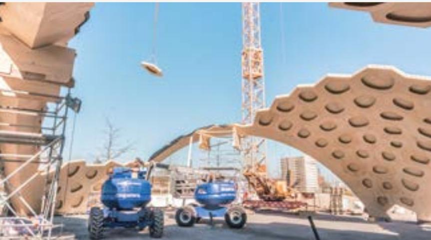
Le pavillon s'appuie sur le principe biomimétique consistant à utiliser « moins de matériaux » en ayant « plus de forme », tant au niveau de la coque globale que de ses segments individuels. Afin de minimiser la consommation de matériaux et le poids, chaque segment de bois est construit à partir de caissons creux en bois aux formes polygonales. Assemblée, la coquille en bois du pavillon a une portée de 30 mètres sans poteaux, mais ne pèse que 36 kg/m<sup>2</sup>.
