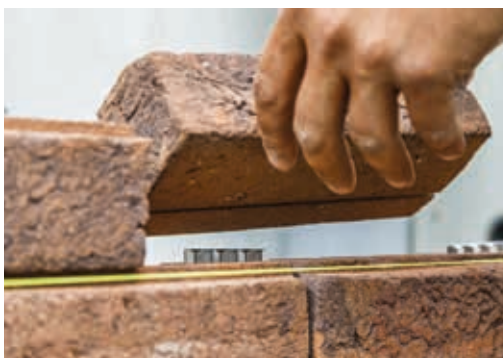
ClickBrick Pure – un système de superposition à sec.
