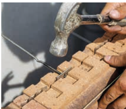
ClickBrick Pure – des crochets d'ancrage assurent l'ancrage de la façade du mur creux
