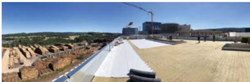
Avec le panneau de laine de roche haute qualité Smartroof, Knauf Insulation offre la solution thermo-acoustique ( $\lambda D = 0,037$  ou  $0,038$  W/mK selon l'épaisseur) qui garantit :
