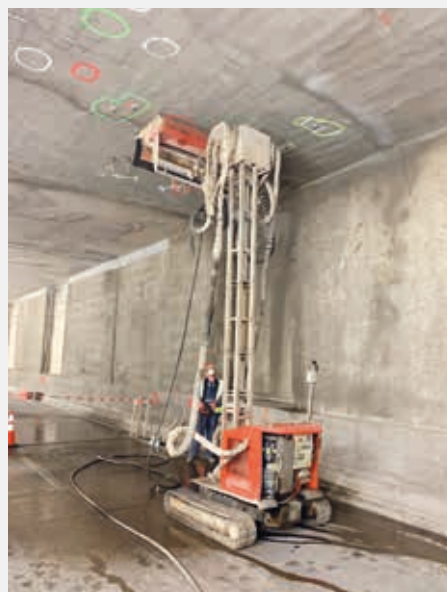
Plafond tunnel Bruxelles – Hydrodémolition jusqu'à 4 cm.
