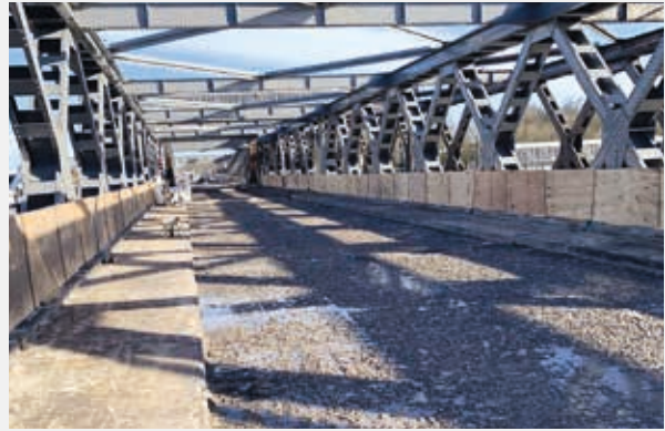
Pont à Temse – hydrodémolition à 2 cm après nettoyage.
