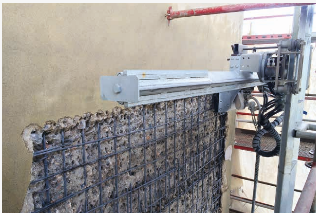
Boekentoren Gent à 50 m de haut sur échafaudage – Profondeur 6 cm
