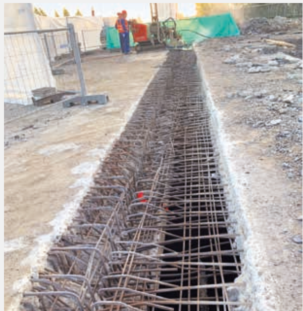
Pulvérisation d'un joint jusqu'à 70 cm de profondeur à Alost.
