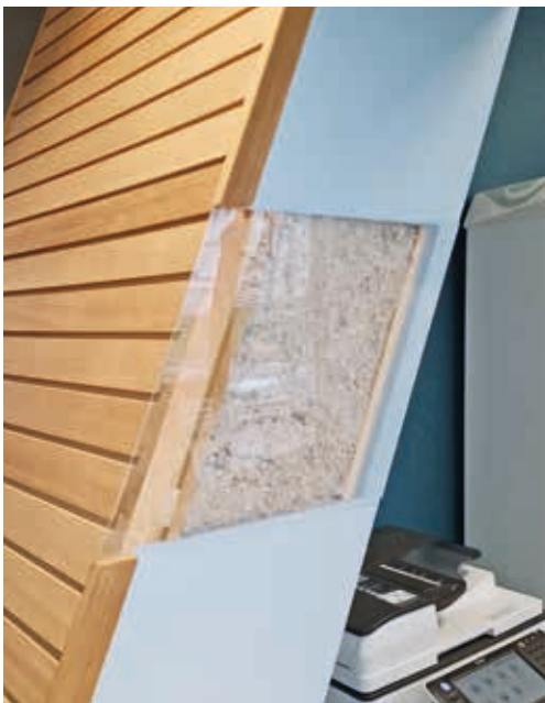
Pour sensibiliser les utilisateurs, nous avons par exemple réalisé une coupe recouverte de plexiglas dans l'ossature bois
