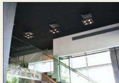
Panneau acoustique en laine de roche de forte densité dont la face visible a une finition noire lisse. L'autre face est munie d'un contrevoile. Les bords des panneaux sont entièrement peints. Ces panneaux autoportants sont posés dans un système invisible facilement démontable.
