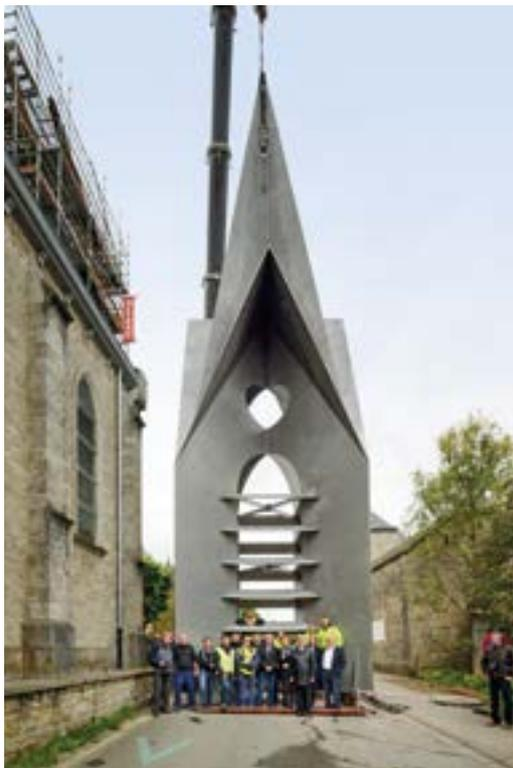
Le projet consiste à démonter la partie la plus dégradée du clocher pour la remplacer par une structure en tôles d'acier inoxydable sablée, reprenant la silhouette du clocher existant. Cette structure a l'avantage d'être naturellement stable, légère et durable.
