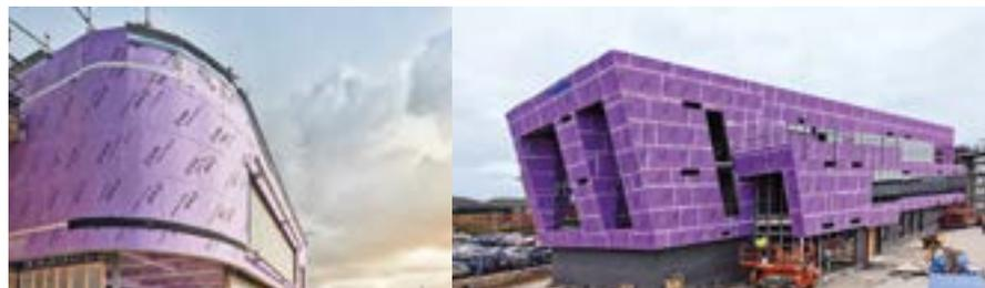
Defence en 20 mm a une bonne résistance au contreventement, ce qui permet de l'utiliser pour améliorer l'effet diaphragme de parois à ossature bois et ossature métallique. Par ailleurs, la plaque Weather Defence peut être courbée pour des applications dans des façades fléchies.
